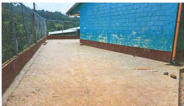
Foto 1: MEJORAMIENTO DE LOSA DE PATIO
